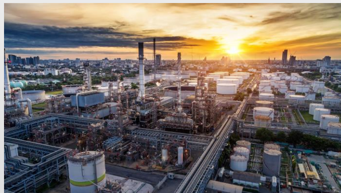
Immagine gentilmente concessa da Siemens
