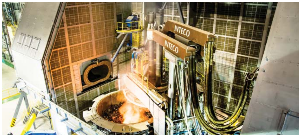
Anlagen von Inteco decken ab dem Hochofen die gesamten Herstellungsprozesskette für Stahl und Superlegierungen ab.
