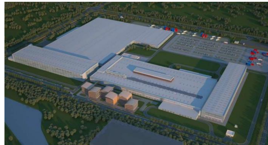
Tianjin Plant and R&D center 天津工厂与研发中心
