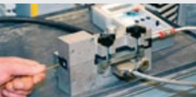
Mit Hilfe von Luftdruck wird die Glasfaser eingeblasen, unter kontrollierter Luftzufuhr und Geschwindigkeit
